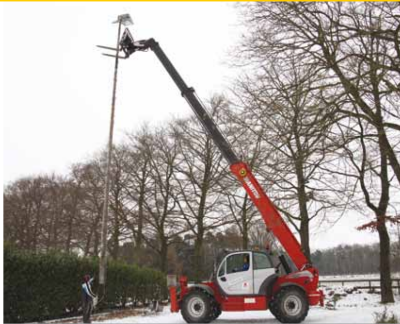
Samen de schouders eronder: twee extra lichtenmasten geïnstalleerd voor nog geen 2.000 euro.
